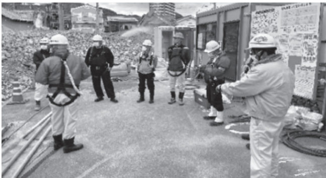
(市営住宅解体工事)
