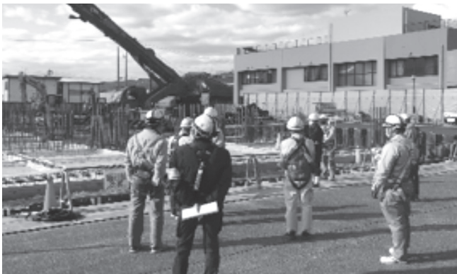
(マンション新築工事)
