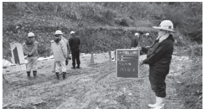
(河川災害復旧工事)
