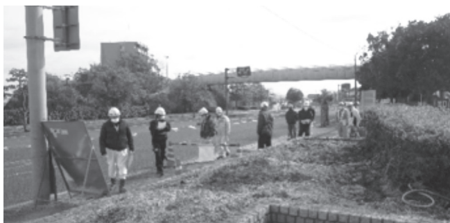
(港線道路再生改良工事)
