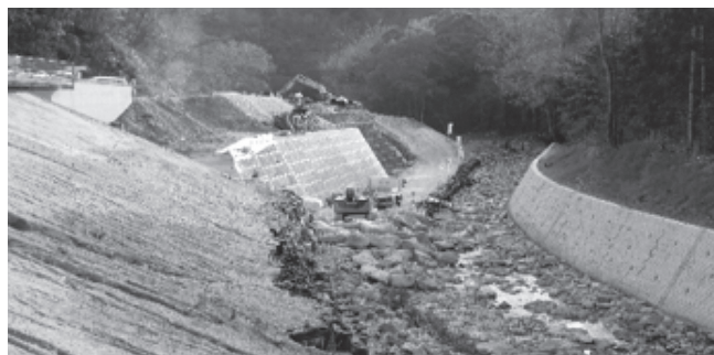
(溪流上部砂防堰堤工事)
