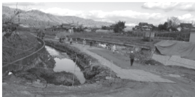
(戸島川災害復旧工事)
