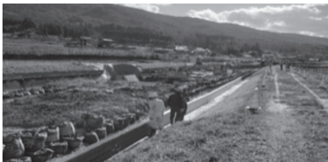
(戸島川災害復旧工事)
