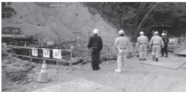
(溪流上部砂防堰堤工事)
