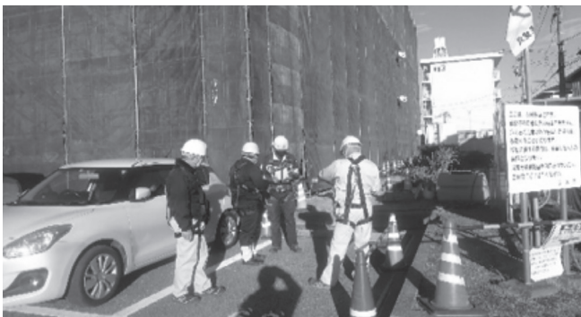
(外壁改修工事)
