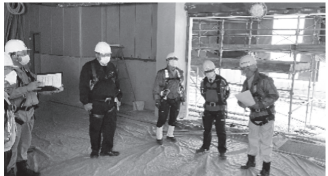
(新社屋建築工事)
