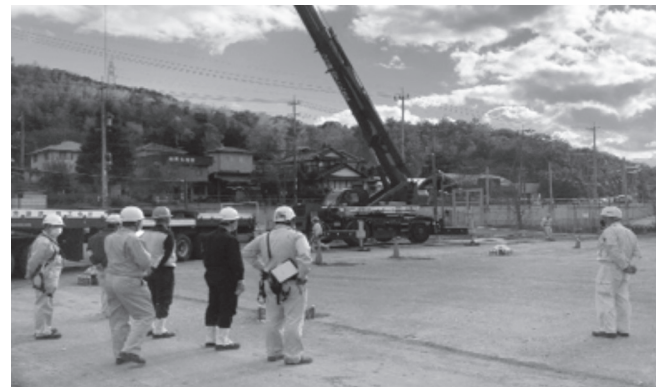
(会社技術開発センター新築工事)
