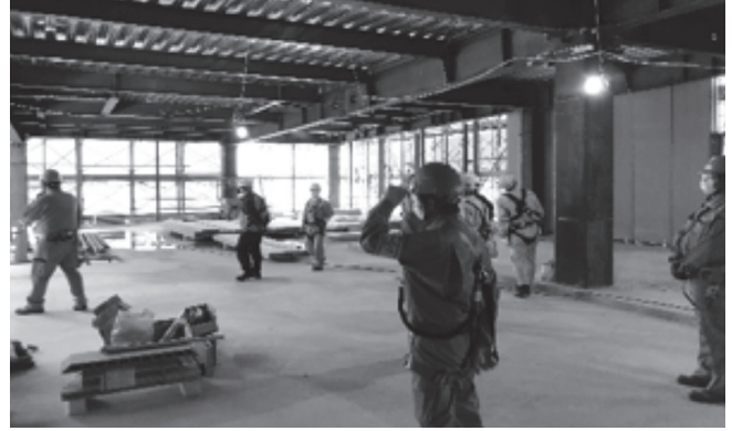
(会社事務所ビル新築工事)
