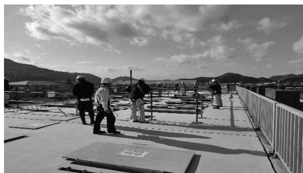
沼田川浄化センター工事
