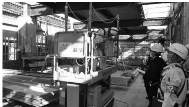
広島地家裁福山支部庁舎新営建築工事
