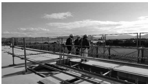
沼田川浄化センター工事
