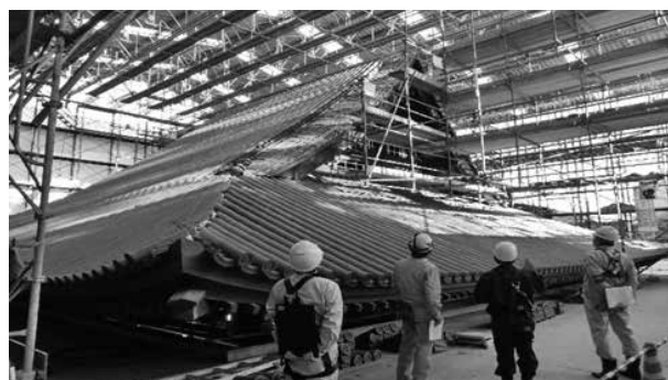
常称寺建造物保存修理工事
