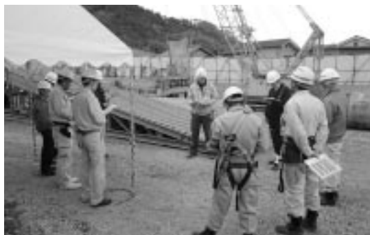
木原道路福地第7改良工事
