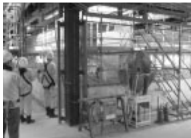
グリーンハウス宏喜苑建替工事
