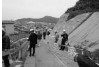
広島西部山系白石地区管理用道路工事
