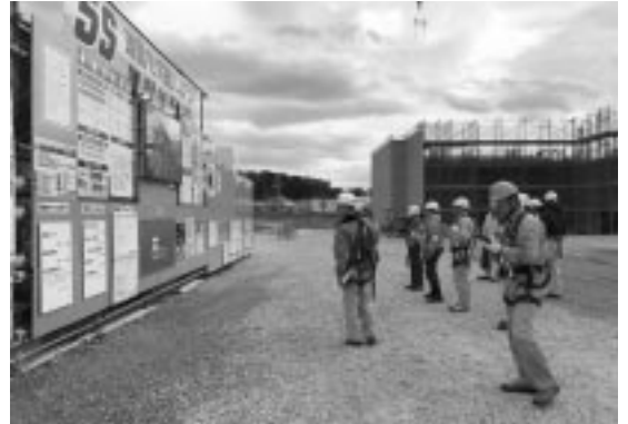
安芸郡マンション新築工事
