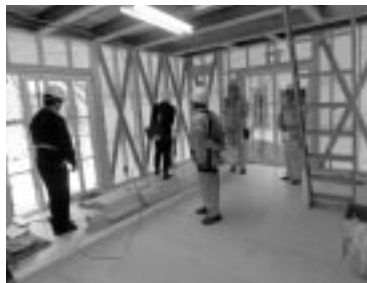
木造住宅新築工事
