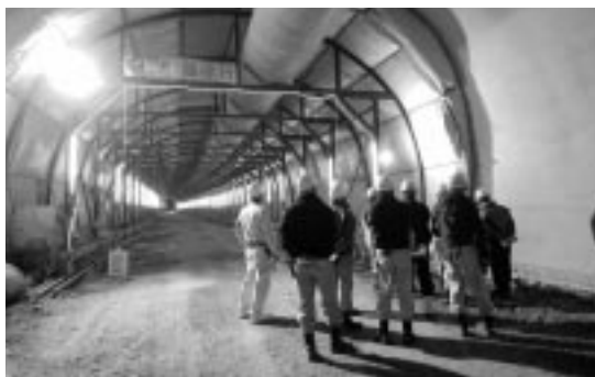
木原道路内島トンネル工事
