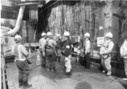
西区配水管シールド工事
