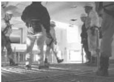
深津保育所新築工事
