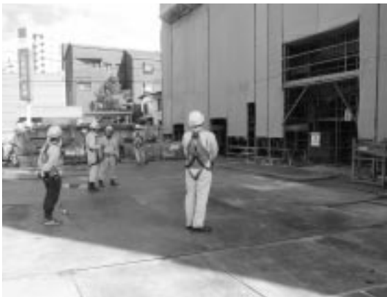
(マンション工事現場のパトロール)
