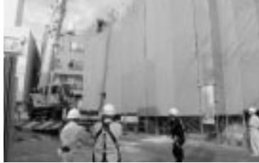
(マンション新築工事現場)
