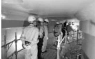
(貯水池耐震補強工事現場)
