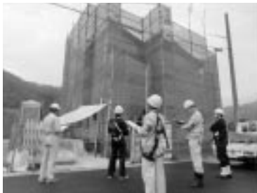
(河本邸新築工事現場)
