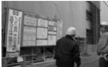
((仮称)アルファライフばら公園新築工事現場)
