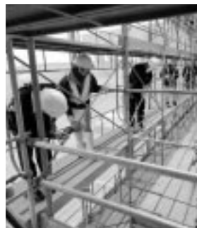
(三次市生涯学習センター耐震改修工事現場)
