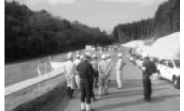
(焼却施設敷地造成工事現場)
