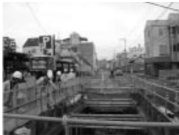
(久保長江線道路改良工事現場)
