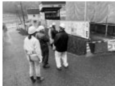
(町菅井折住宅新築工事現場)
