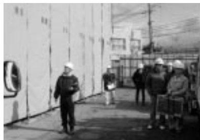
(廿日市市庁舎耐震改修工事現場)
