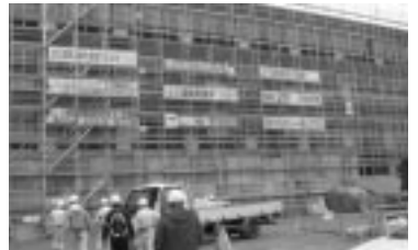
(盈進高等学校耐震改築工事現場)
