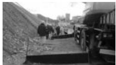
(木原道路内島高架橋工事現場)
