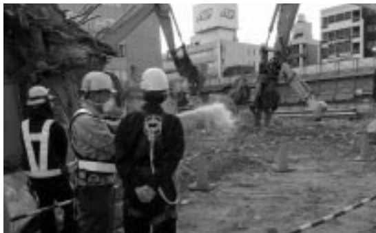
（現場のパトロール状況）
