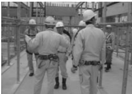
マンション工事現場のパトロール
