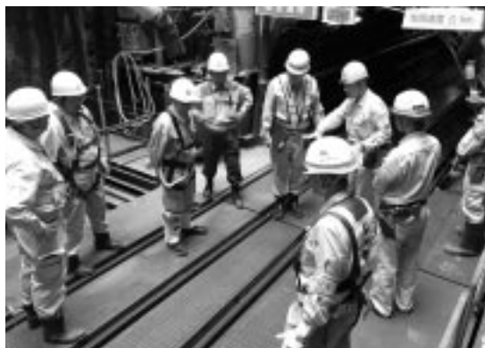
シールド工事現場のパトロール
