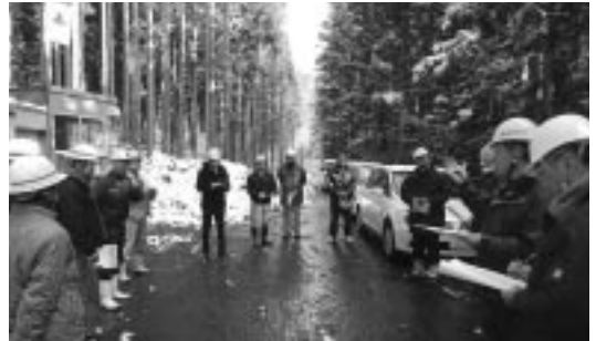
林道悪谷線開設工事
