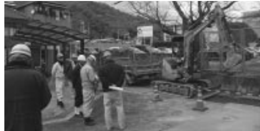
三原東処理分区汚水管新設工事
