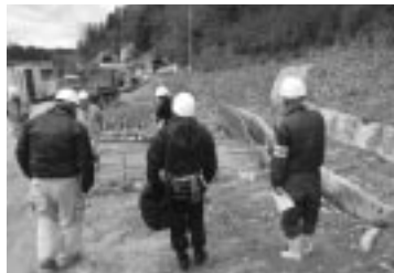
町道安田徳市線道路改良工事
