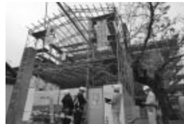
重要文化財 常称寺本堂他2棟建造物保存修理第1期工事
