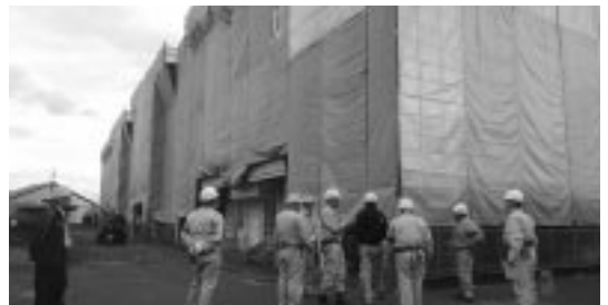
県営住宅外壁改修工事
