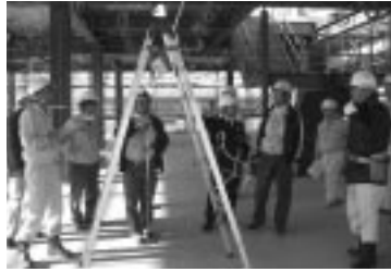
脳神経センター大田記念病院回復リハビリ病棟増築工事
