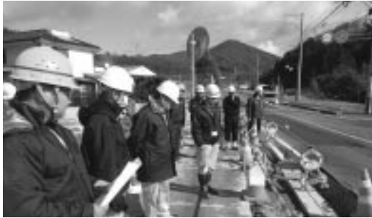
廿日市佐伯線 交通安全施設等整備工事
