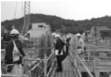
(仮称)ポレスター尾道栗原西新築工事
