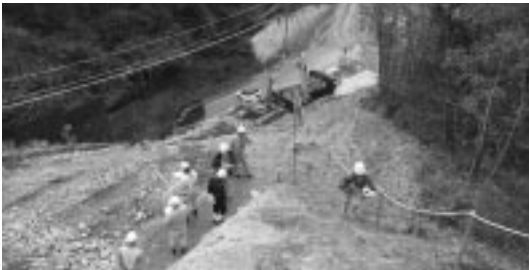
一般県道三原本郷線道路改良工事
