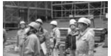
西区ND聖心講堂建設現場
