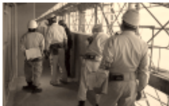
福山市深津住宅3号棟(27.高耐)建設工事
