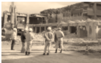
尾道市立大学校舎撤去その他工事
