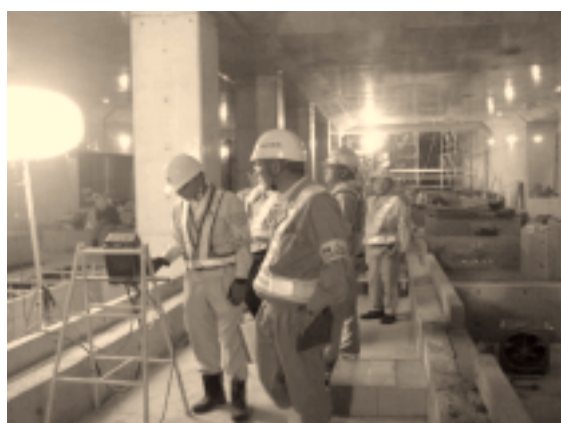
新交通新駅 地下ホーム付近のパトロール
