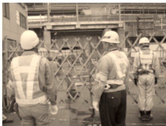
JR新駅 北側駅舎建設現場
