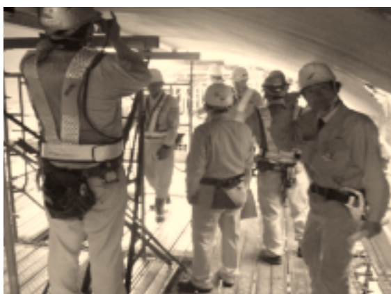
新交通新駅 ドーム屋根裏の足場
